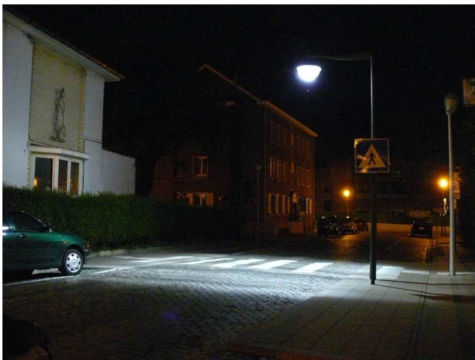
Figura 4-18 Illuminazione artificiale attraversamenti pedonali (Bruxelles 2010)
